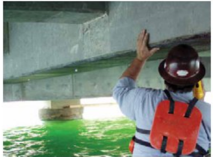
Fig. 3: FRP 콘크리트 시스템을 검사하는 조사관
