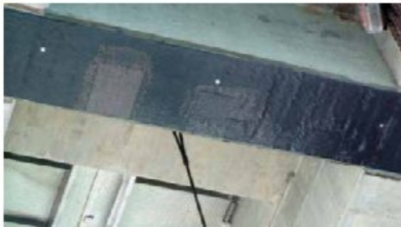
그림 1: 콘크리트 빔에 외부 결합된 FRP
